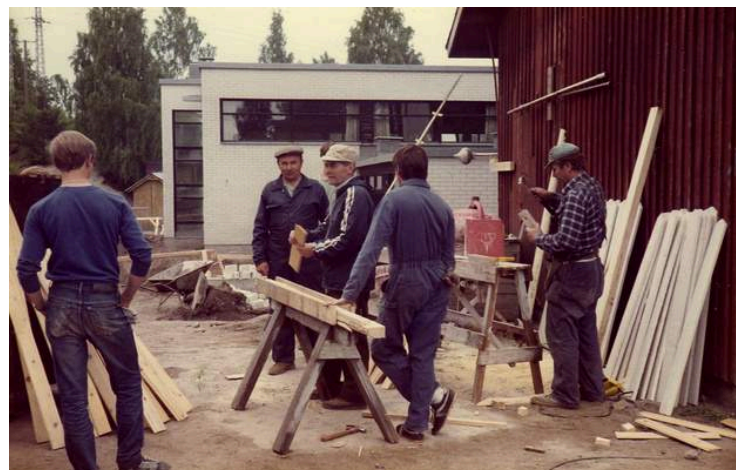
Ensimmäistä laajennusta rakentamassa 1984
